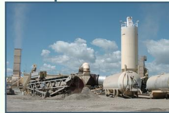
Usine d'asphalte utilisant la méthode d'application à sec. De gros réservoirs servent à entreposer l'hydrate, l'asphalte et le combustible du brûleur sur place.
