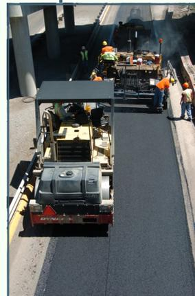
L'épandeuse étend l'asphalte, suivie d'une série de rouleaux compacteurs.
